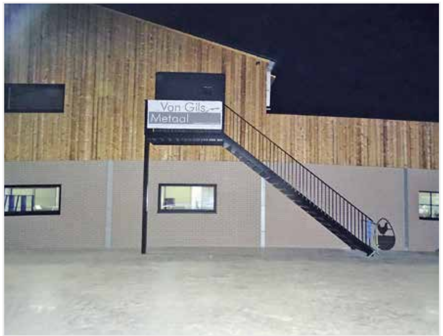
Een bezoekersruimte, die eveneens als vergaderruimte kan gehuurd worden, is boven het eierlokaal voorzien. Bemerkt eveneens de thermowood afwerking van de stal voor de inplanting in harmonie met de omgeving.
