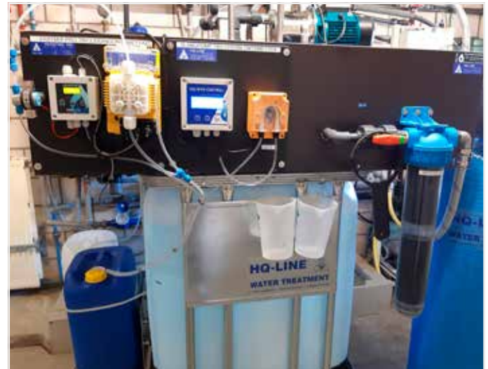
Foto 1: Behandeling van regenwater op basis van een 'zuiveringstrein'
