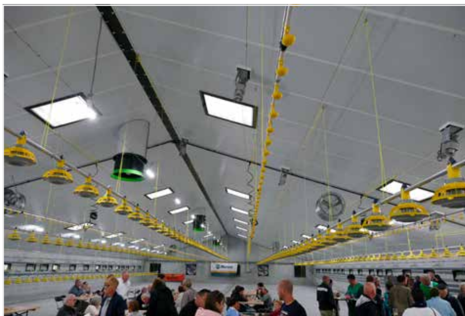
Vier rijen regelbare dakramen zorgen voor een homogene lichtinval.
