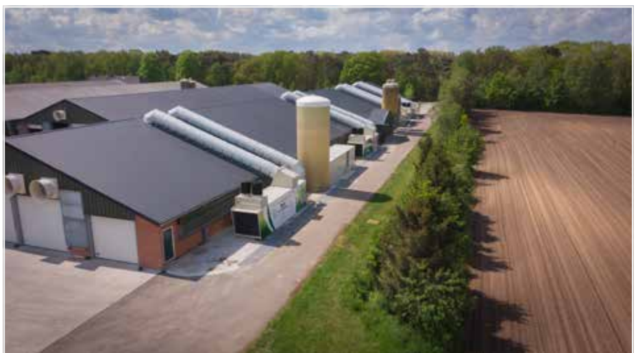
Op dit moederdierenbedrijf te Hoogeloon (NL) werden de eerste proefunits geïnstalleerd en werd 90% van de ammoniak afgevangen in het spuiwater (Foto Vencomatic).
