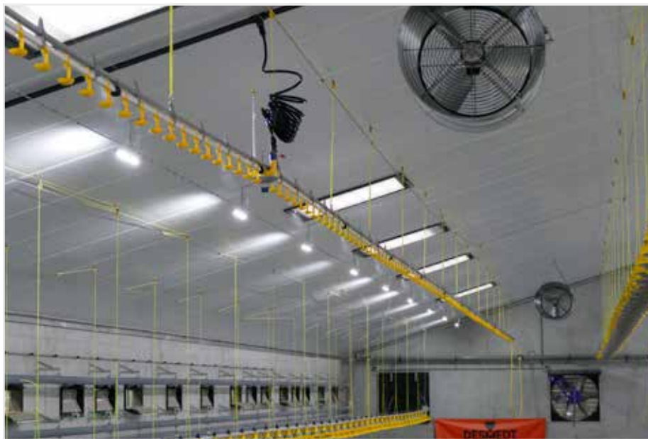
Om een homogene menging en luchtcirculatie in de stal te bekomen, met de buizenverwarming, zijn er 6 circulatieventilatoren aan het plafond opgehangen; 3 in beide richtingen.
