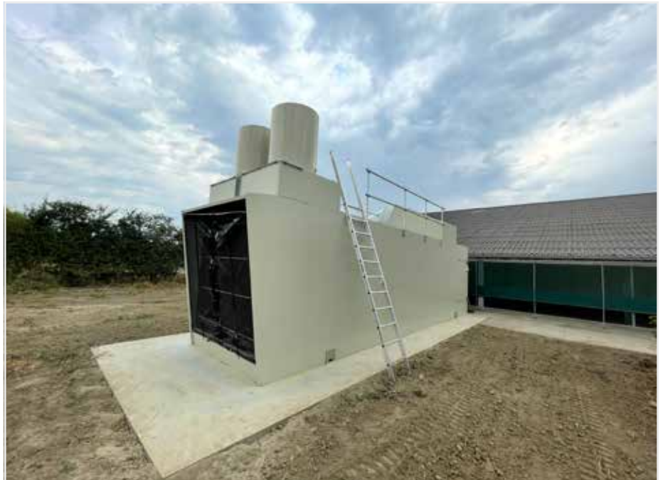
De ECO Air Care unit combineert de functies van warmtewisselaar, koeling en luchtwassing (Foto Vencomatic).
