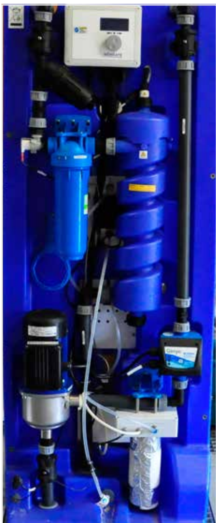
◀ Het Proefbedrijf Pluimveehouderij gebruikt voor de drinkwaterontsmetting een UV-ozontoestel (bron: H2Ozone).
