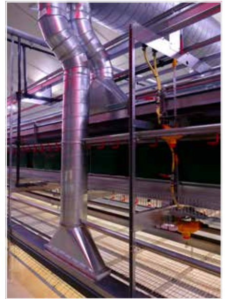
Mestbandroging via voorverwarmde lucht van de warmtewisselaar wordt toegepast en dit op beide niveau's.
