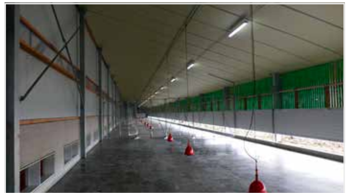
In de wintertuin zijn plassondrinkers aangebracht, drie voor iedere groep van 6.000 kippen. Bemerkt de 'space boarding' en eronder sandwich panelen die omhoog kunnen schuiven.
