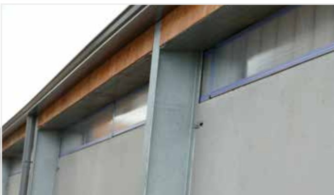
Langs beide zijden is een lichtstraat met regelbare, contra roterende lamellen die voor een totale verduistering kunnen zorgen.
