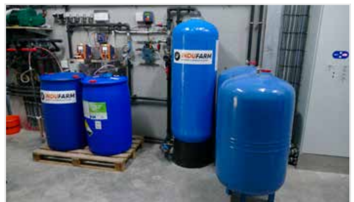
Het drinkwater (2/3 stadwater, 1/3 boorwater) wordt aangezuurd en vervolgens ontsmet vooraleer het naar de drinksystemen gestuurd wordt.
