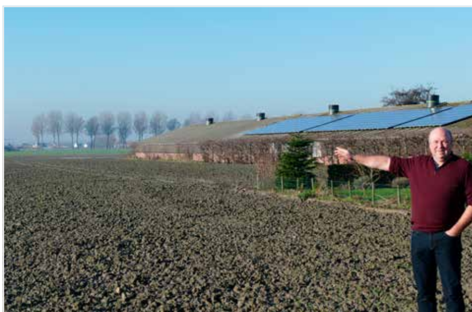
Chris voor de braadkippenstal met de reeds in 2007 gelegde zonnepanelen. De nabijheid van de A11 (Brugge-Knokke) verhinderde de uitbreiding van de braadkippentak.
