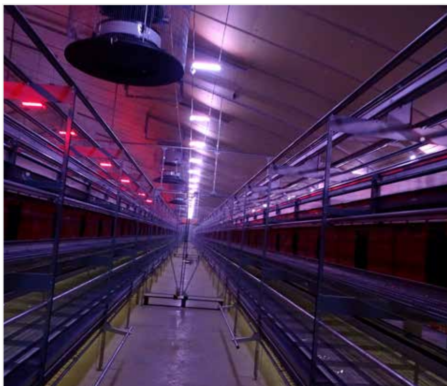
Legkippenstal met verschillende, afzonderlijk dimbare LED verlichtingslijnen.
