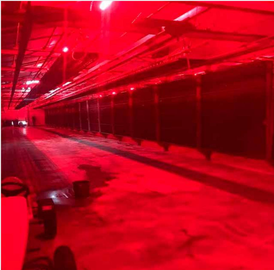
Opfokstal met een combinatie wit/rode ledverlichting in dezelfde armatuur die eveneens in productiestallen voor leg- en moederdieren gebruikt wordt.
