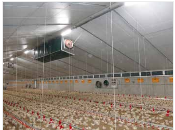
De ingeblazen lucht van de warmtewisselaars wordt 'opgevangen' in de nok en vandaaruit via circulatieventilatoren homogeen verspreid in de stal.
