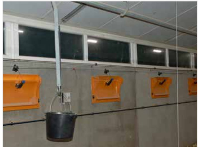
De stallen zijn uitgerust met een lichtstraat die buiten met een doek kan afgedekt worden. Bemerkt verder de nevelkoeling en de 'kadaverlijn' om in de lange stallen de dode kippen vlot te kunnen verzamelen.
