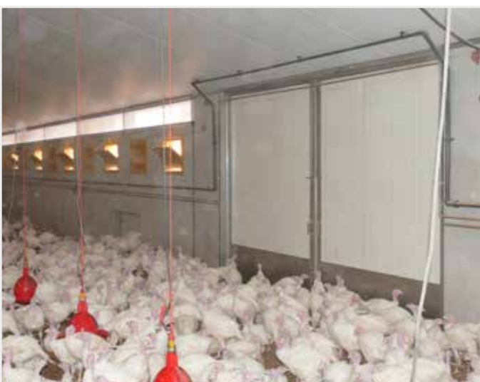
De nieuwe stallen zijn uitgerust met een lichtstraat, nevelkoeling en een zijdelinkse poort om de kalkoentjes over de grond vanuit de opfokstal te kunnen drijven.
