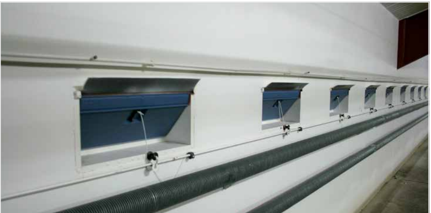
De warmwaterbuizenverwarming is een AEA systeem dat het laatst werd toegevoegd aan de lijst en ook zorgt voor de hoogste reductie.
