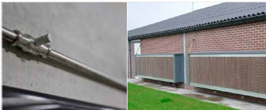
Fig. 1: Links close-up van een hogedrukvernelingsstelsel boven de luchtinlaten in de stal; rechts pad koeling voor de luchtinlaten van de stal.
