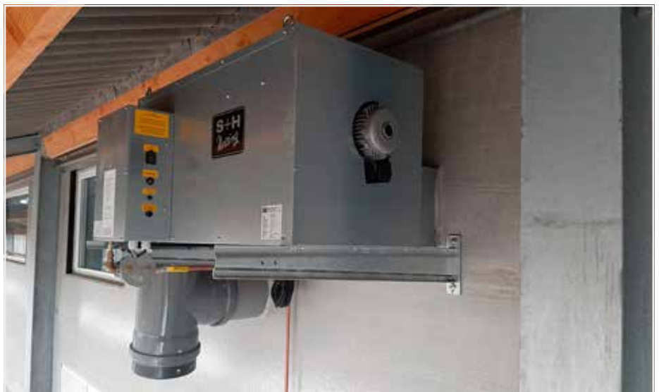
De stal wordt verwarmd met gasbranders bevestigd aan de muur tussen scharrelruimte en wintertuin.
