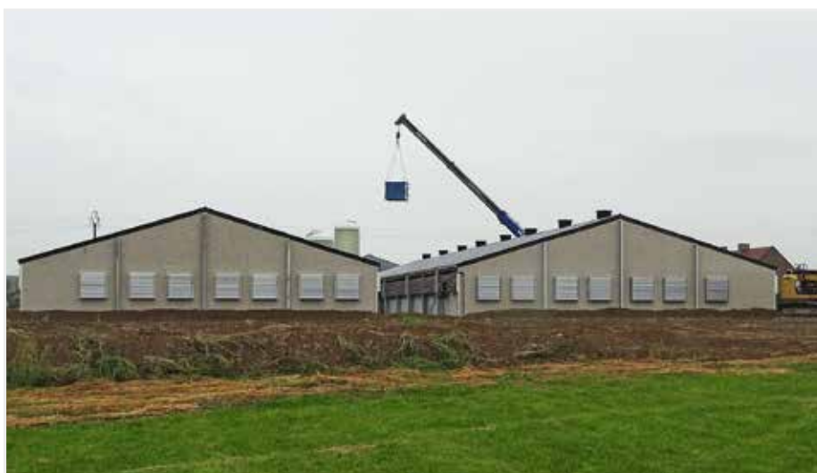
Achteraanzicht op de 2 stallen. Bemerk de ventilatoren zowel in de nok als achtergevel en de voederkeuken tussen de 2 stallen.
