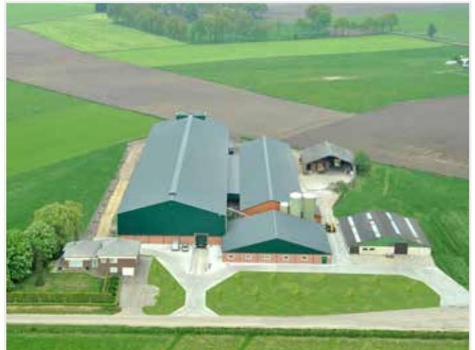
Het bedrijf met de grote en hoge legkippenstal en ernaast de oudere kippenstal die nu als mestruimte dienst doet. Vooraan het eierlokaal en nog wat restanten van het vroegere melkkoeienbedrijf.
