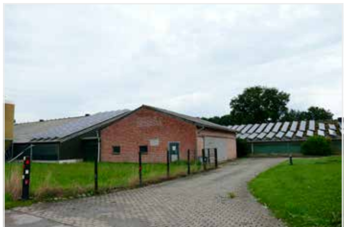
Ondanks dat de twee stallen reeds meer dan 10 jaar oud zijn, zijn ze uitgerust met een emissiearm systeem, een overdekte wintertuin en zijn de daken bedekt met zonnepanelen.
