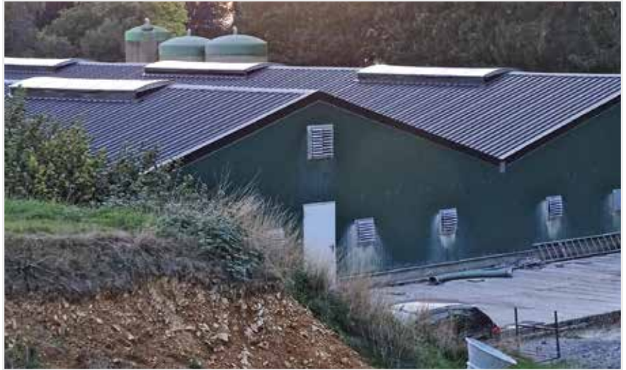
Recent werden dakvensters in alle stallen aangebracht om tegemoet te komen aan de Duitse eis voor natuurlijk licht. Een kost van meer dan 40.000 euro.
