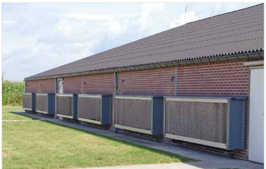
Voor het vleeskippenonderzoek is één van de stallen met padkoeling uitgerust en de andere stal met nevelkoeling. Tijdens de hittegolf waren de kuikens maar 2 weken oud en bleef de temperatuur in beide stallen onder de 32°C.
