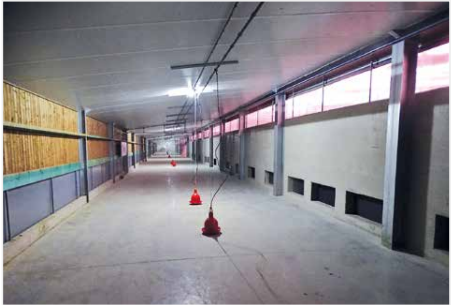
In legkippenstallen met wintertuin kan extra drinkwatergelegenheid en eventueel nevelkoeling soelaas brenegen.
