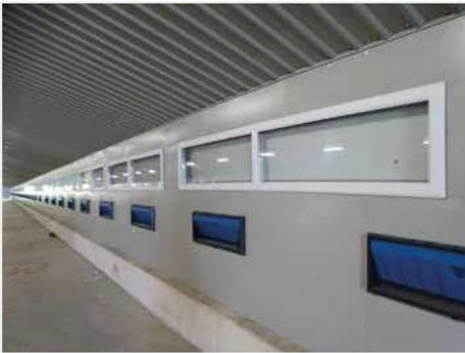
Binnenzicht in de nieuwe stallen. Merk de vensters die slechts indirect diffuus licht toelaten. De koeling moet nog geïnstalleerd worden.
